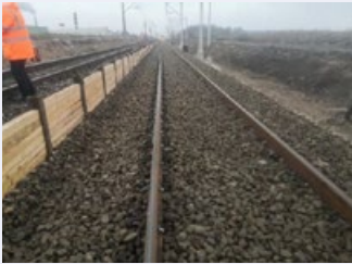
Reused old ballast
